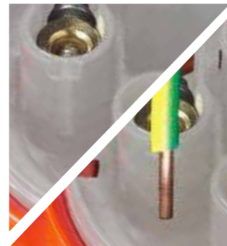
2 PELADO DE LOS CABLES
