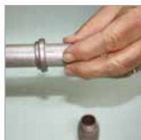
Introduce the joint sealing into conduit. Introducir la junta de vedación en el electroducto.
