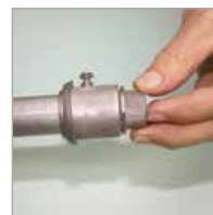
Slide the joint sealing for conduit until cover up the conector. Deslizar la junta de vedación para el electroducto hasta cubrir el conector.
