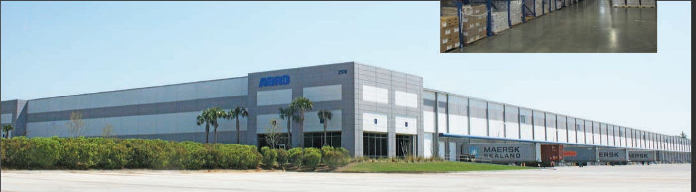
Centro de Servicios de distribución ABRO Savannah, Georgia, U.S.A.
