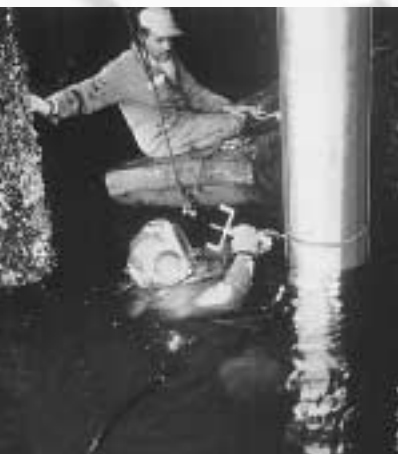
Aplicadas tanto sobre, como bajo el agua, las abrazaderas BAND-IT sostienen con gran fuerza.
